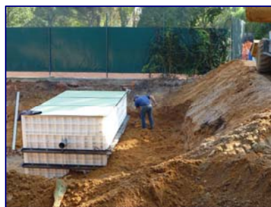
Photos ci- dessus : livraison,, installation, et site terminé - station de 100 équivalents- habitants , au LAGARDERE RACING CLUB - LA CROIX CATELAN - PARIS , BOIS DE BOULOGNE
