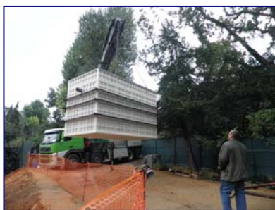
Photos ci- dessus : livraison,, installation, et site terminé - station de 100 équivalents- habitants , au LAGARDERE RACING CLUB - LA CROIX CATELAN - PARIS , BOIS DE BOULOGNE
